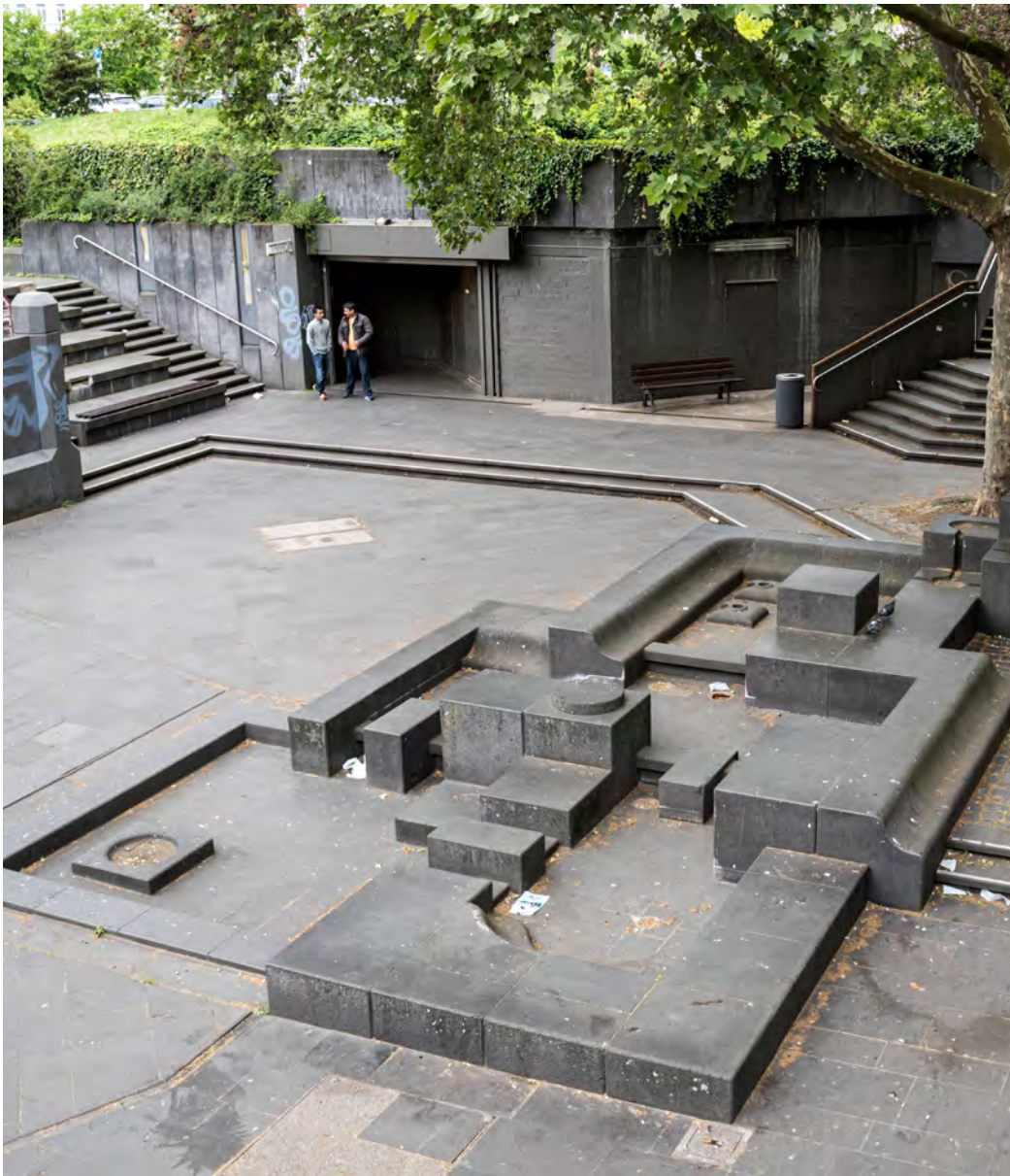
Das Bonner Loch 2016, vor Abriss und Umbau
